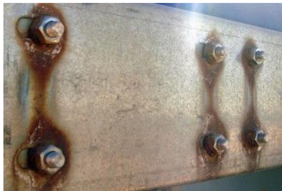
Gambar 5. Korosi galvanis (kajianpustaka.com)
