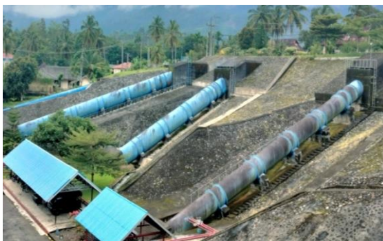
Gambar 3. Gambar Ketinggian Head Penstock PLTA Tes
