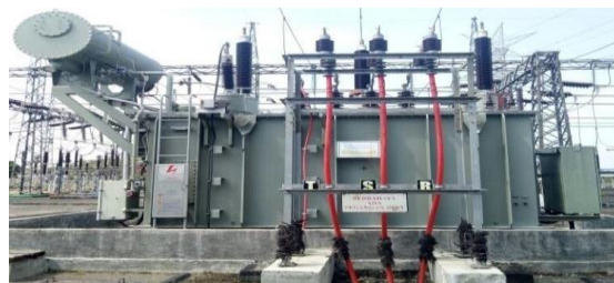
Gambar 1. Transformator Daya 30 MVA di Gardu Induk Lahat
