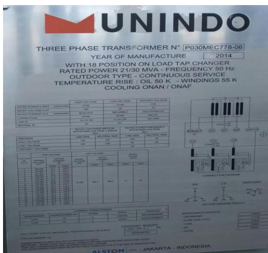
Gambar 2 Name Plate Trafo Daya 30 MVA Gardu Induk Lahat
