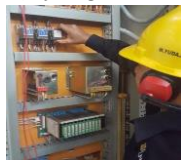
Gambar 13 Proses melepas relay di panel
