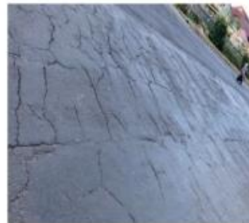
Gambar 3. Retak Blok
