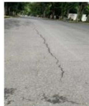
Gambar 4. Retak Memanjang/ Melintang
